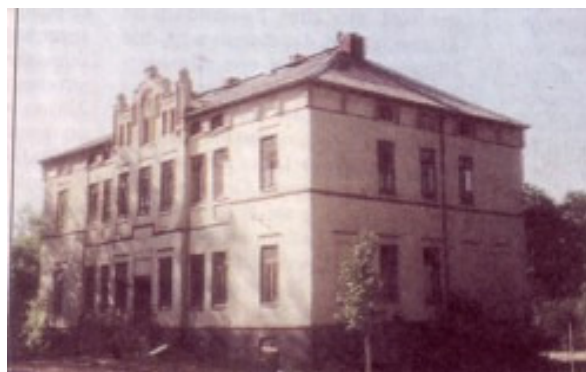
Das Gutshaus in Rakow noch vor der unlängst begonnenen Restaurierung. Der Putzbau wurde 1856 1 im Stil der Neugotik errichtet.
