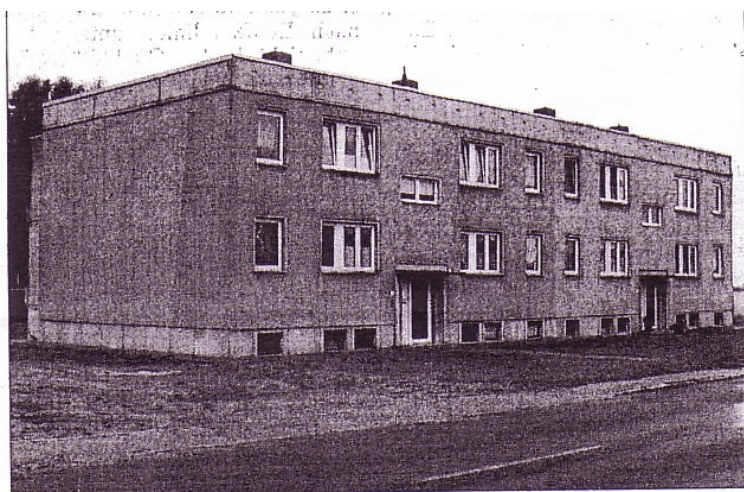
Die Sanierung und Begrünung des Plattenbaus in der Haffstraße ist eine der neun Maßnahmen des öffentlichen Teils des Dorferneuerungsplans.
